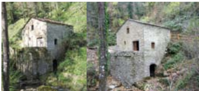
Il Mulino di Morino prima e dopo il restauro
