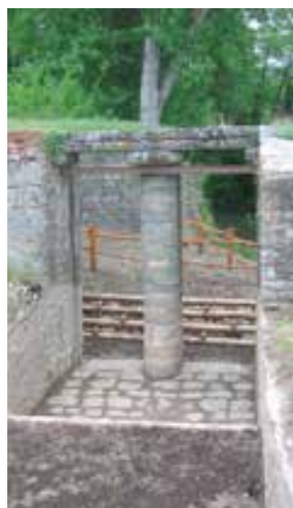
Percorso sulla bonifica, Casa Rossi
