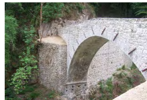
Il ponte dopo il restauro.
